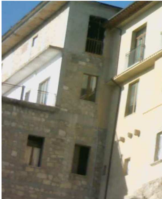
Figura 1 giunzione tra le due strutture
